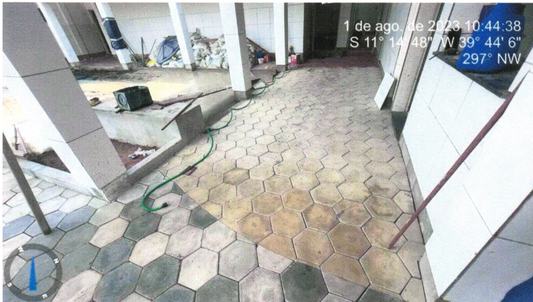
Foto 13 – EXECUÇÃO DE PAVIMENTO EM PISO INTERTRAVADO, COM BLOCO SEXTAVADO DE 25 X 25 CM, ESPESSURA 6 CM.(LARANJA, AMARELO, GRAFITE, NATURA) AF_12/2015
