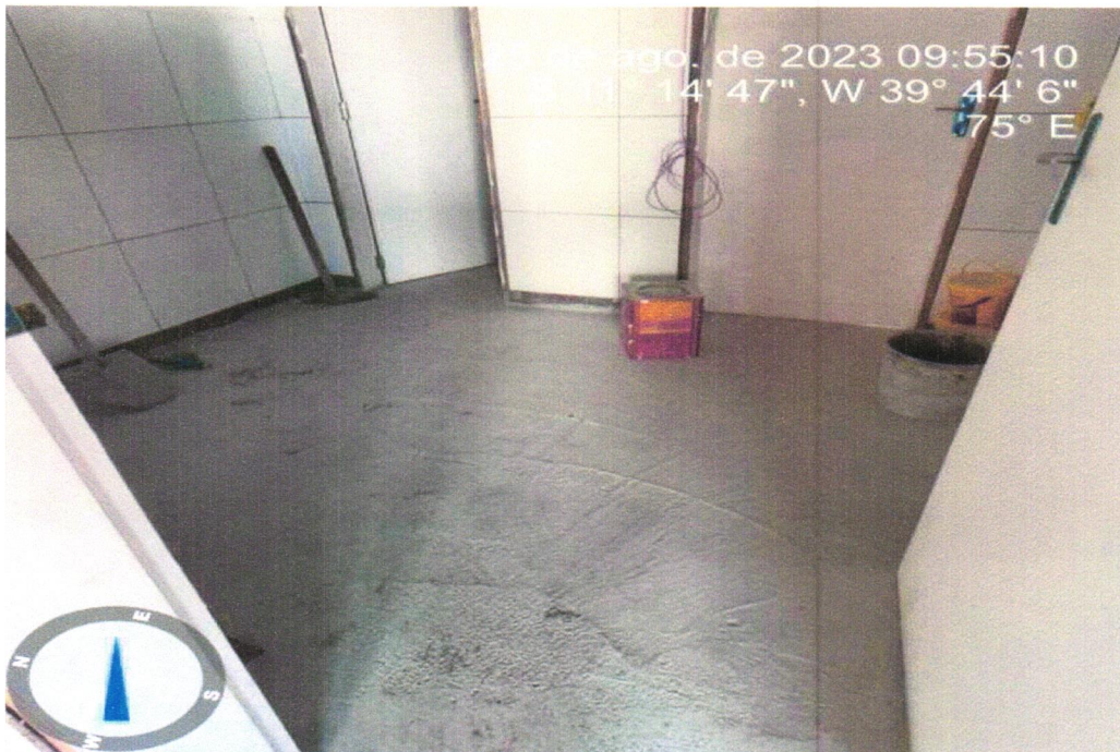
Foto 03 - FECHADURA DE EMBUTIR PARA PORTAS INTERNAS, COMPLETA, ACABAMENTO PADRÃO MÉDIO, COM EXECUÇÃO DE FURO - FORNECIMENTO E INSTALAÇÃO. AF_12/2019
