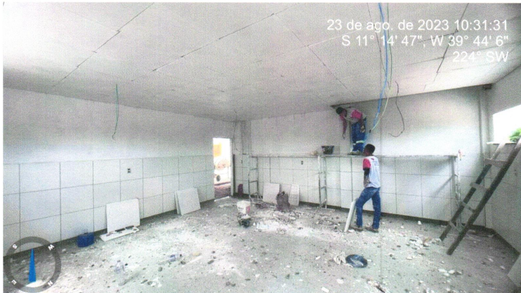
Foto 06 - FORRO EM PLACAS DE GESSO, PARA AMBIENTES COMERCIAIS. AF_05/2017_P
