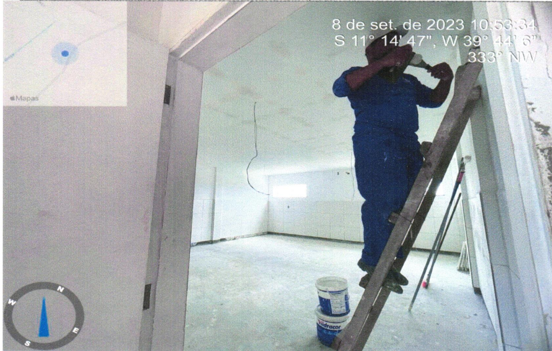
Foto 14 - APLICAÇÃO E LIXAMENTO DE MASSA LÁTEX EM PAREDES, UMA DEMÃO.AF_06/2014
